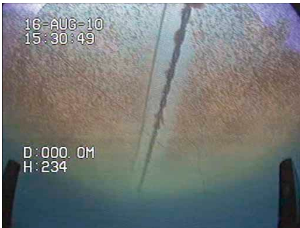
Figur 28 Not med synlig slitasje fra bunnringkjetting.
